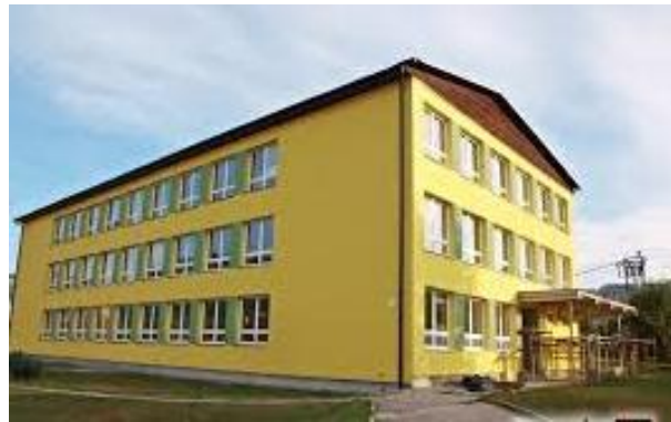
Základná škola po stavebných úpravách
